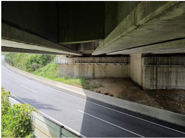
교대 A1 기초 전경
