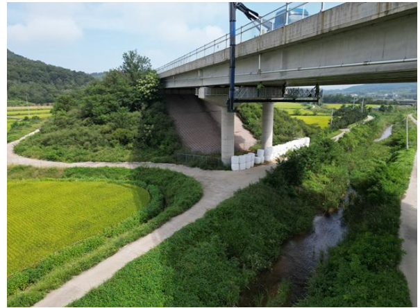
굴절점검차를 이용한 근접조사
