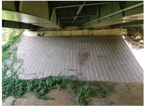
교대 A2 기초 전경
