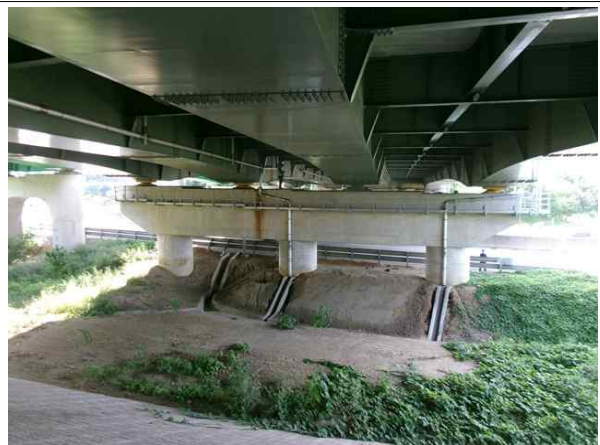
교각 P2 기초 전경
