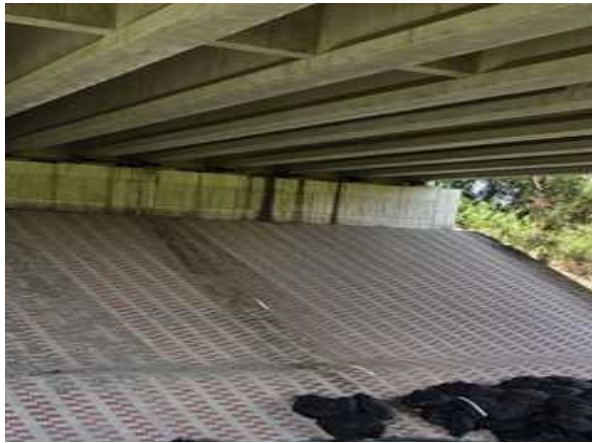
교대 A1 기초 전경
