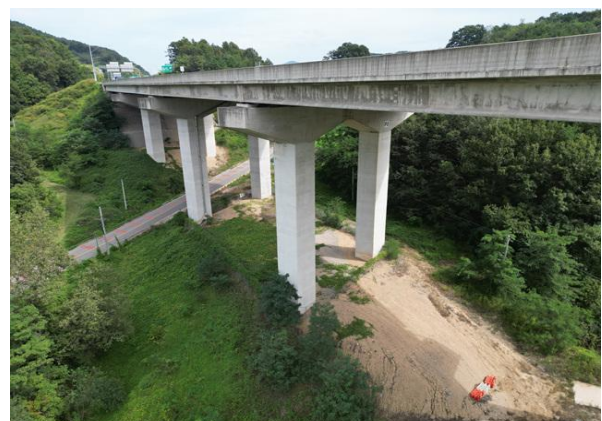
교각 P8~10 기초 전경
