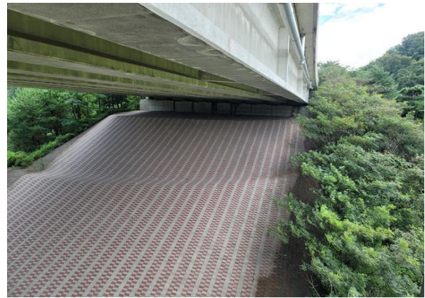
교대 A2 기초 전경
