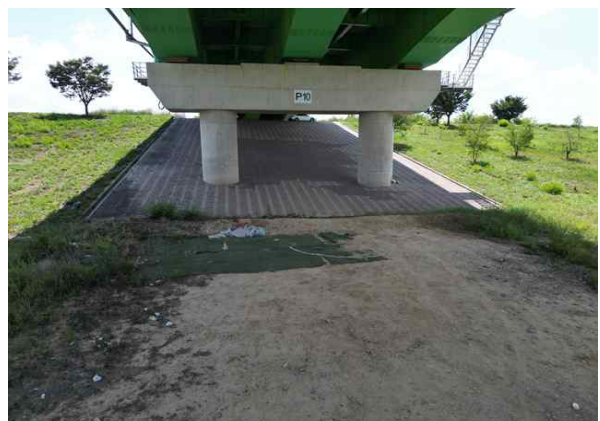
교각 P10 기초 전경
