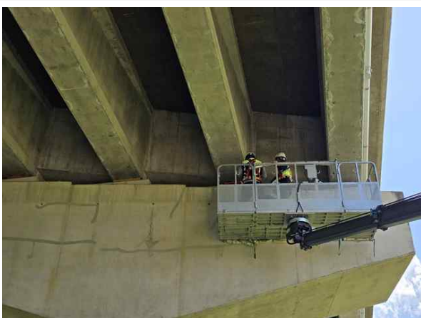
고소점검차를 이용한 근접조사
