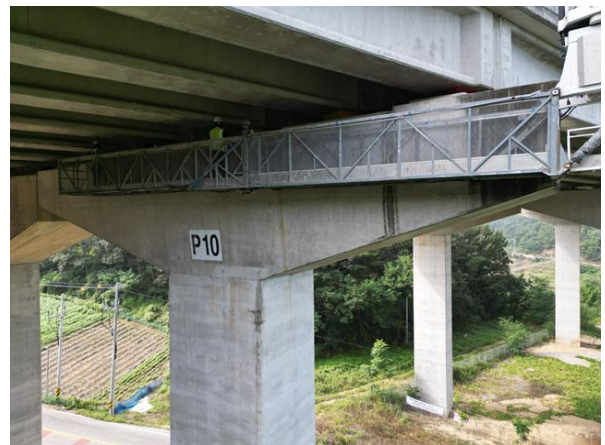
굴절점검차를 이용한 근접조사
