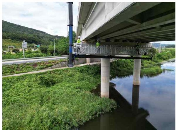
굴절작업차를 이용한 근접조사
