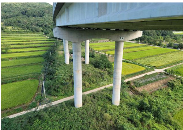
교각 P4~5 기초 전경
