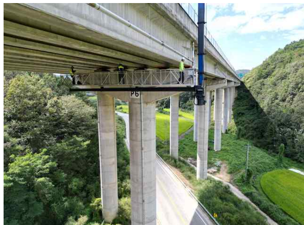
굴절작업차를 이용한 근접조사
