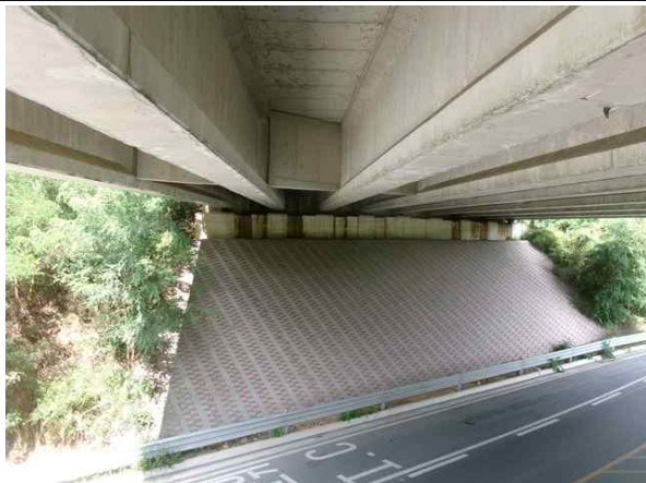
교대 A1 기초 전경
