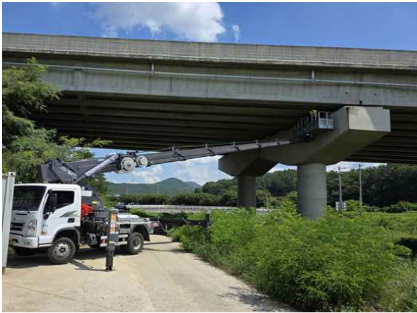
고소차를 이용한 부재치수 현장측정
