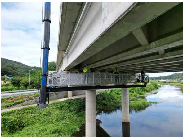
굴절작업차를 이용한 근접조사
