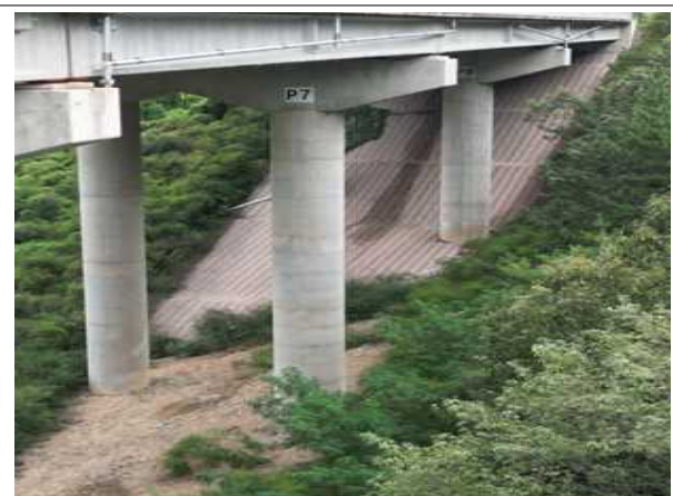
교각 P7~8 기초 전경
