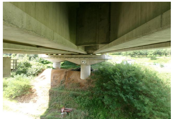
교각 P2 기초 전경
