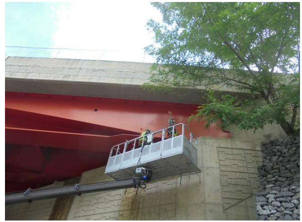
고소작업차를 이용한 부재치수 현장측정
