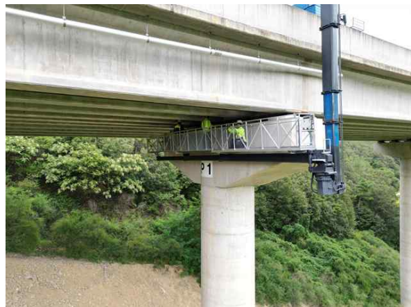
굴절작업차를 이용한 근접조사
