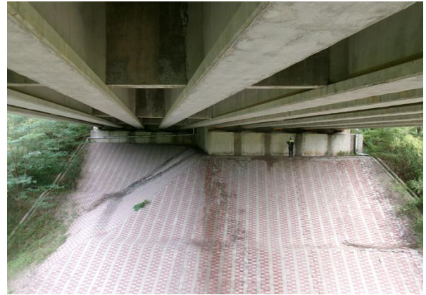
교대 A2 기초 전경
