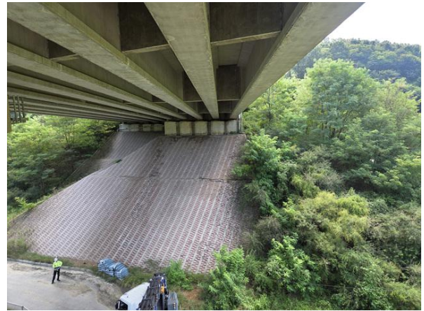
교대 A2 기초 전경
