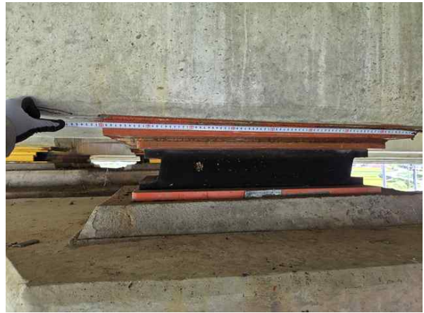
줄자를 이용한 부재치수 현장측정
