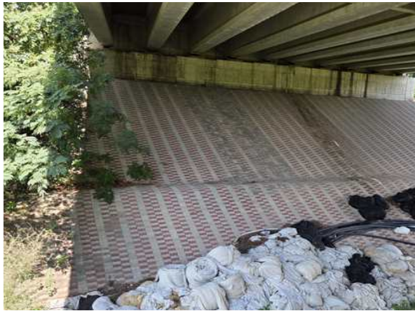
교대 A1 기초 전경
