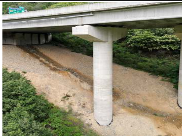
교각 P1 기초 전경
