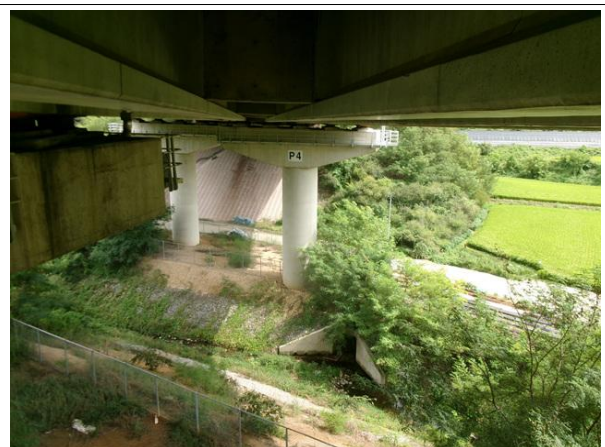
교각 P4 기초 전경
