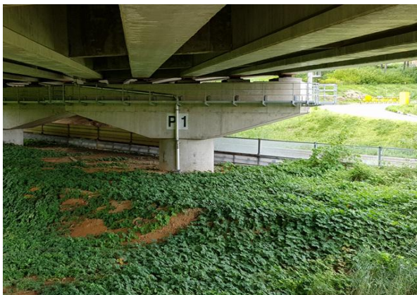
교각 P1 기초 전경
