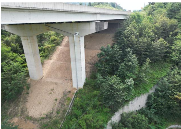
교각 P1 기초 전경
