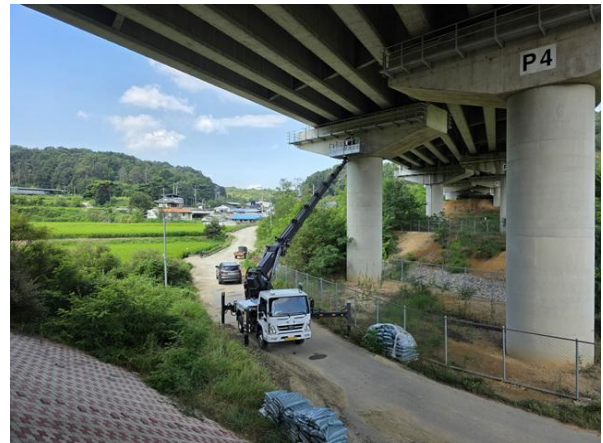
고소점검차를 이용한 근접조사
