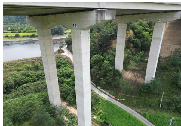
교각 P2~3 기초 전경
