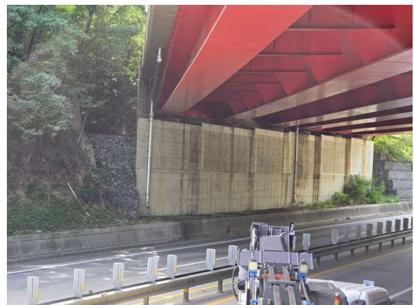
교대 A2 전경
