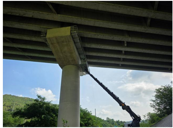
고소점검차를 이용한 근접조사
