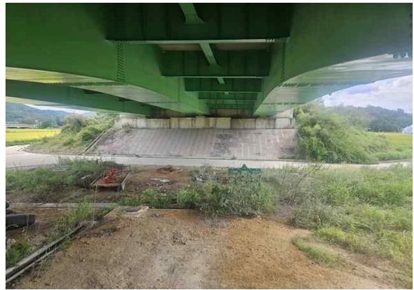
교대 A2 기초 전경
