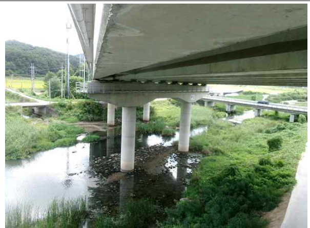
교각 P2 기초 전경
