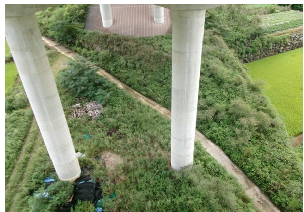
교각 P7~8 기초 전경
