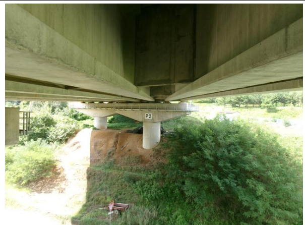
교각 P2 기초 전경
