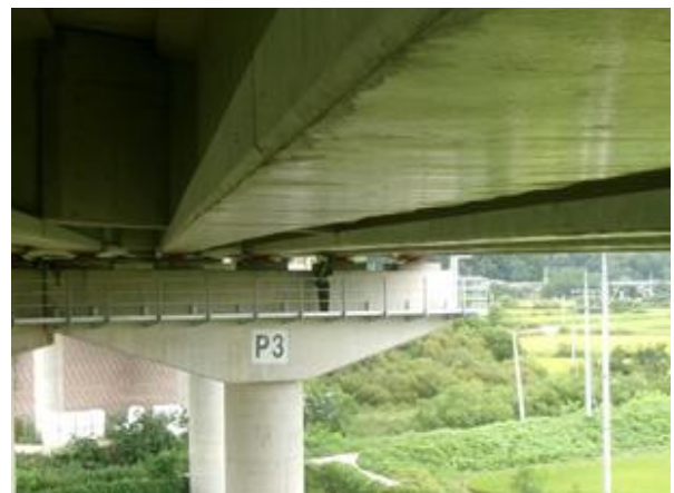
도보를 이용한 근접조사
