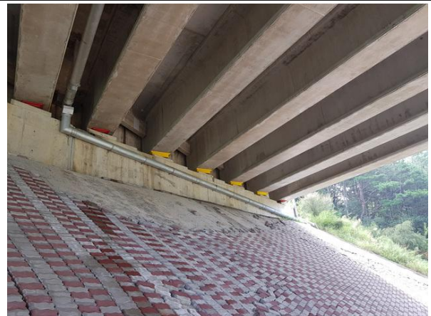
교대 A2 기초 전경
