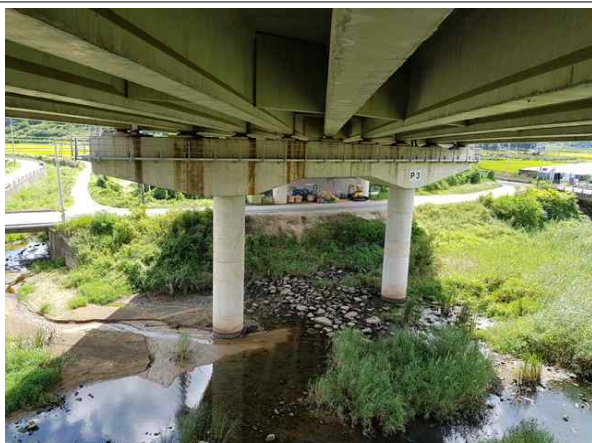
교각 P3 기초 전경
