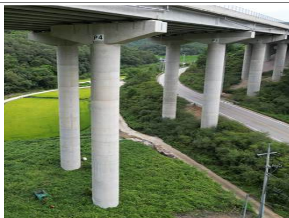
교각 P4~6 기초 전경
