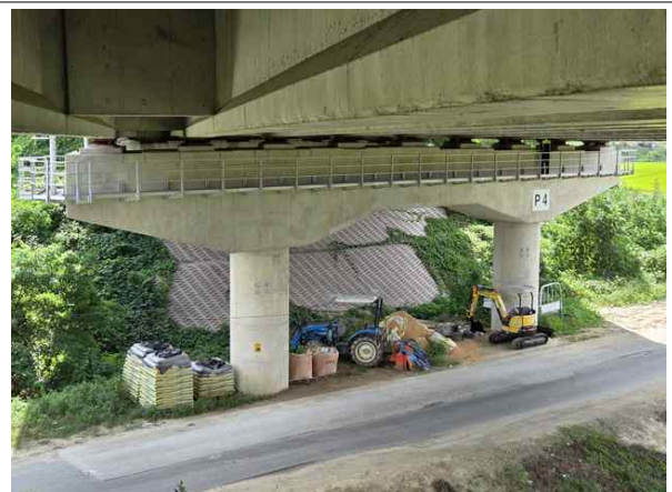
교각 P4 기초 전경
