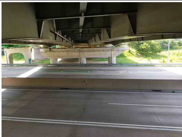
교각 P1 기초 전경
