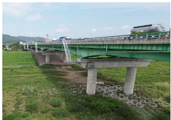
교각 P3~4 기초 전경
