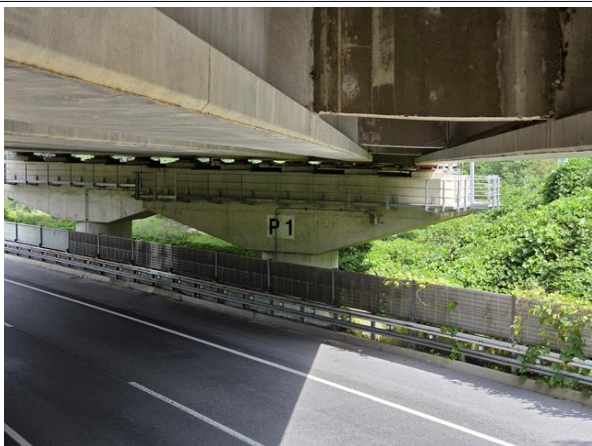
교각 P1 기초 전경
