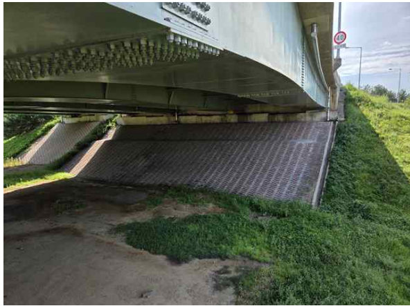
교대 A1 기초 전경
