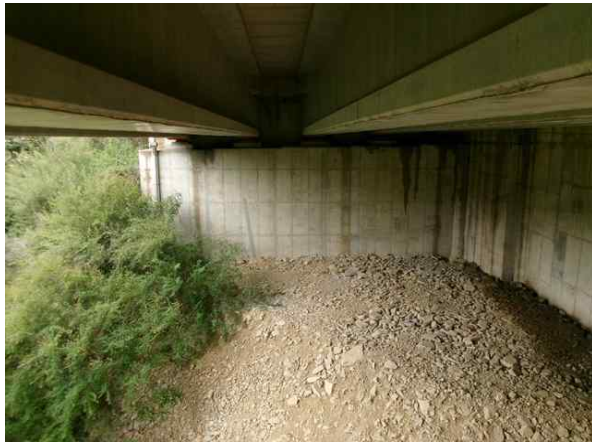
교대 A1 기초 전경
