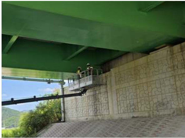
고소작업차를 이용한 부재치수 현장측정
