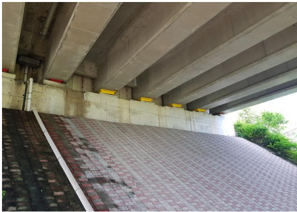
교대 A1 기초 전경
