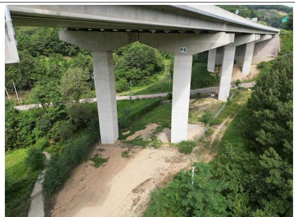
교각 P8~10 기초 전경
