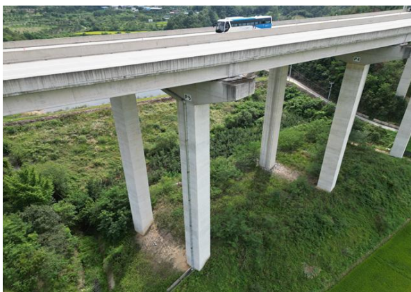
교각 P4~5 기초 전경
