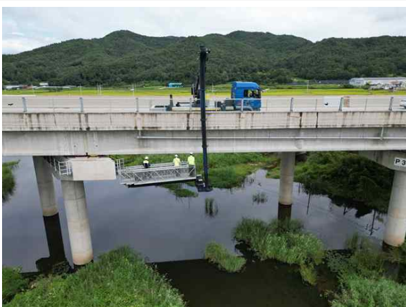
굴절작업차를 이용한 근접조사
