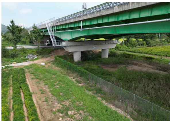
교각 P1 기초 전경
