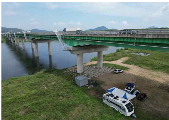
교각 P5~9 기초 전경
