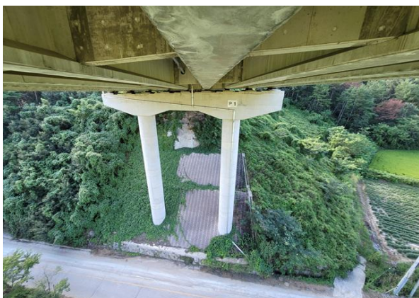
교각 P1 기초 전경
