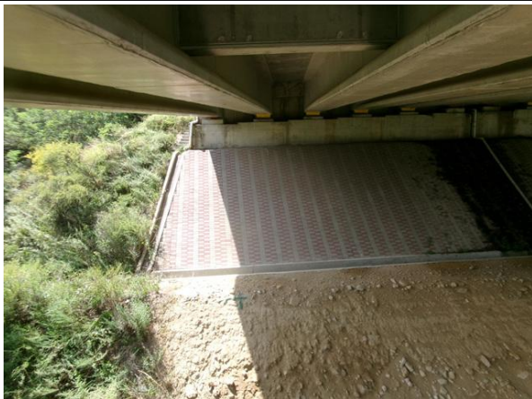
교대 A1 기초 전경
