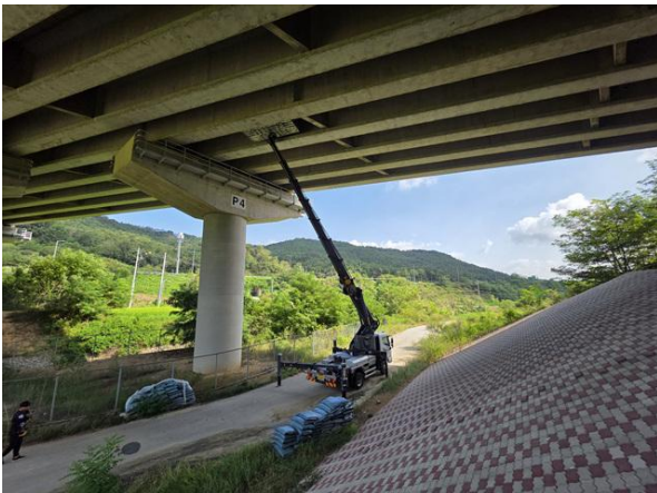
고소점검차를 이용한 근접조사
