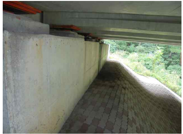
교대 A2 기초 전경
