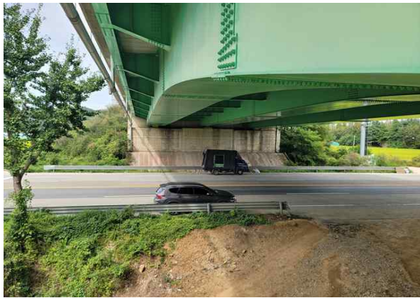
교대 A1 기초 전경
