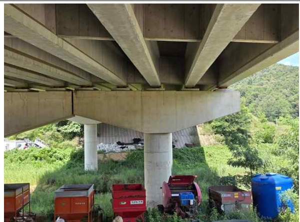
교각 P2 기초 전경
