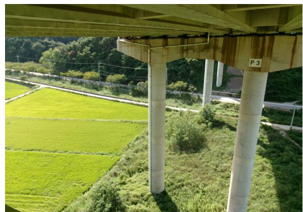
교각 P3 기초 전경
