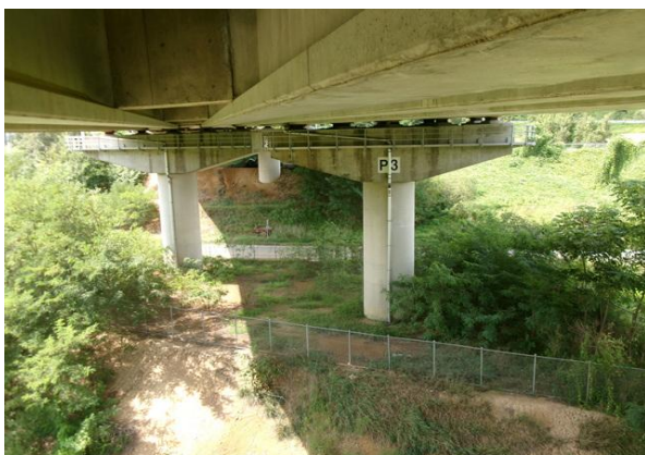
교각 P3 기초 전경
