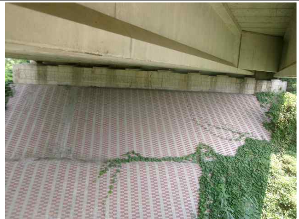
교대 A2 기초 전경
