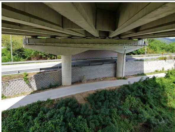
교각 P1 기초 전경
