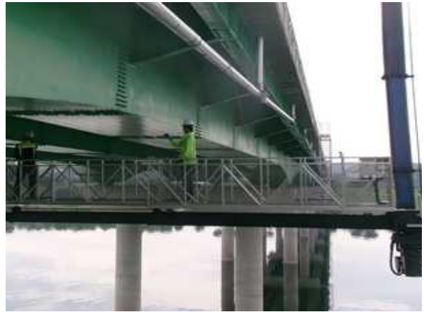
굴절차를 이용한 부재치수 현장측정
