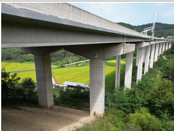
교각 P1 기초 전경
