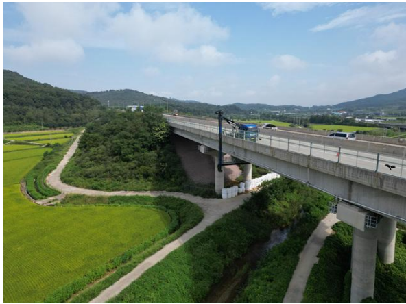
굴절점검차를 이용한 근접조사
