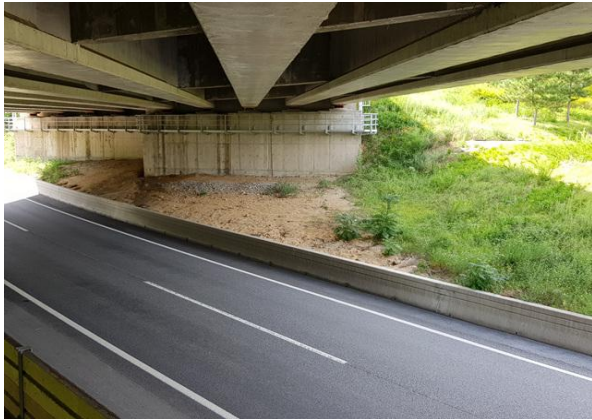
교대 A1 기초 전경
