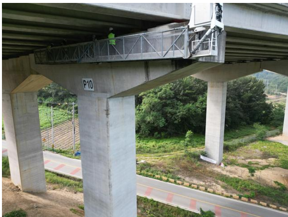
굴절점검차를 이용한 근접조사
