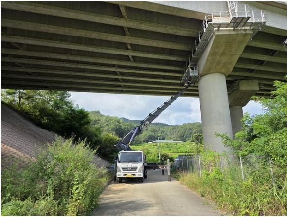
고소점검차를 이용한 근접조사
