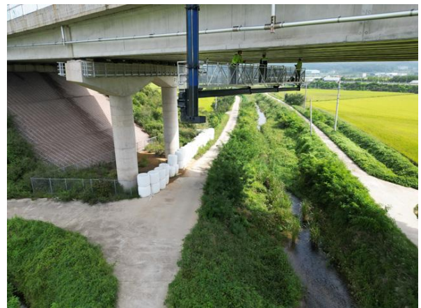
굴절점검차를 이용한 근접조사
