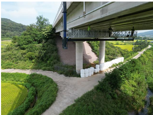
굴절점검차를 이용한 근접조사
