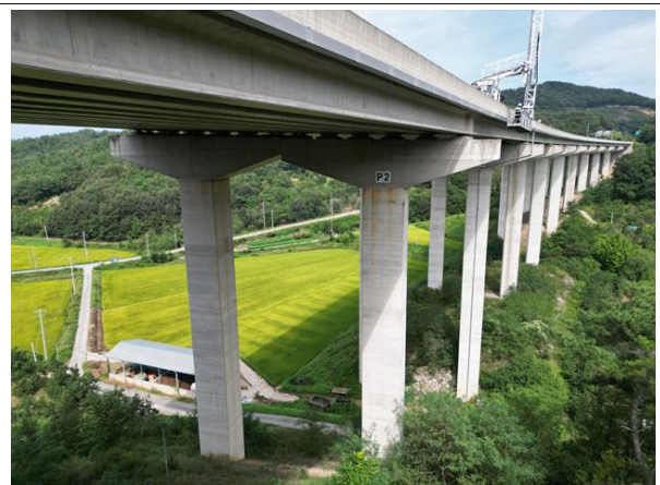
교각 P2~3 기초 전경
