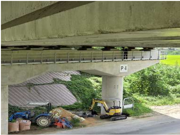
도보점검을 이용한 부재치수 현장측정
