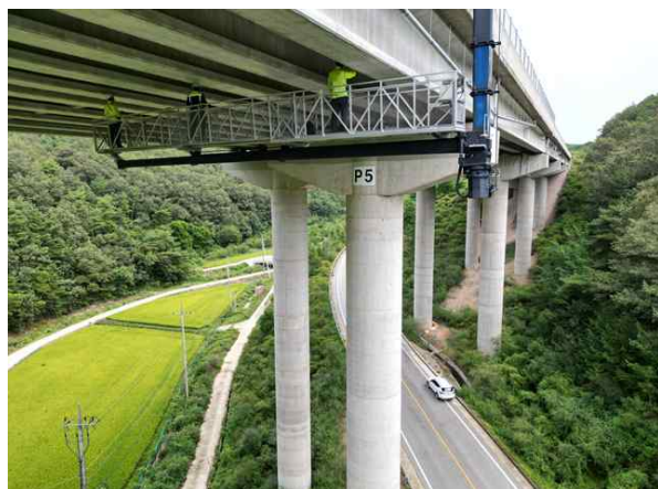
굴절작업차를 이용한 부재치수 현장측정
