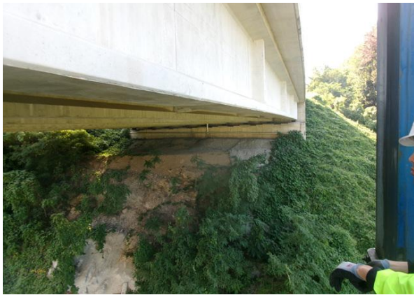
교대 A1 기초 전경
