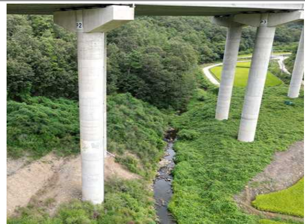
교각 P2~3 기초 전경
