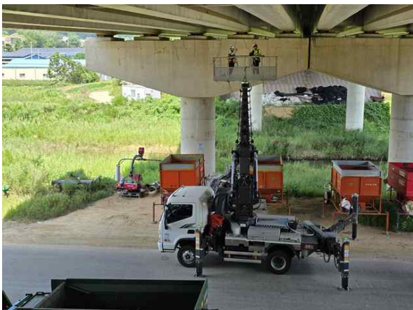
고소점검차를 이용한 근접조사
