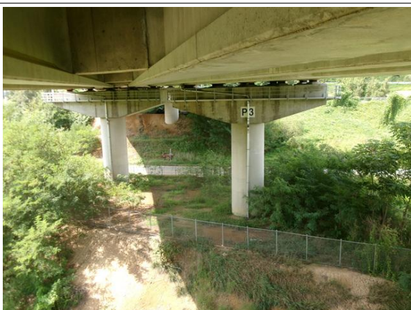
교각 P3 기초 전경
