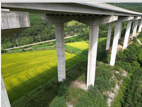
교각 P4~5 기초 전경
